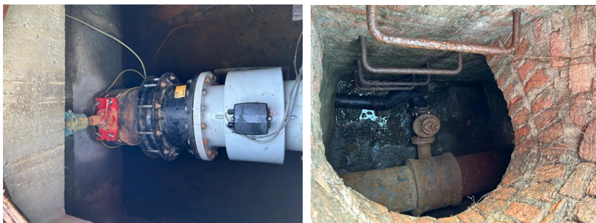
Figura 17 – a sinistra foto del pozzetto di misura, a destra il pozzetto di scarico a monte della camera esistente di interruzione.
